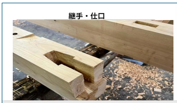
図 5-18 継手・仕口の画像
